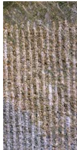
Rainurage de gradine à dents sur calcaire d'Ancaster
