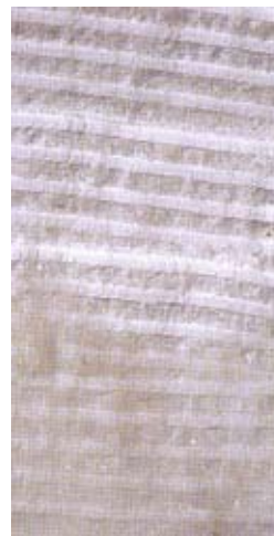
Albâtre rainuré à la gradine dentée
